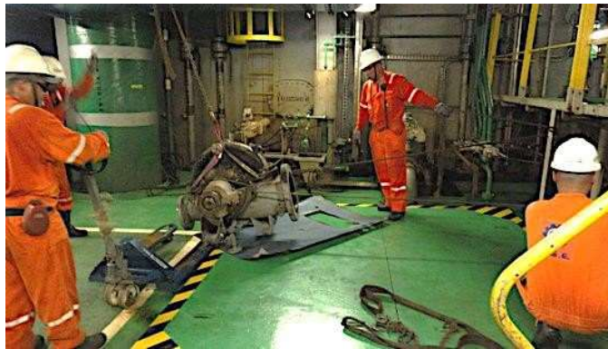
Figura 4 - Los usuarios ensamblan un sistema con polipastos y cables para asignar la bomba a la transpaleta
