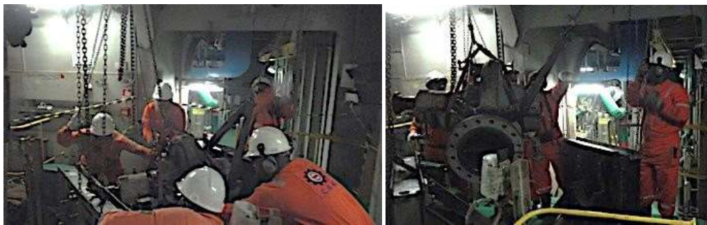
Figura 2 - Extracción del soporte y extracción de la bomba de la cuna
