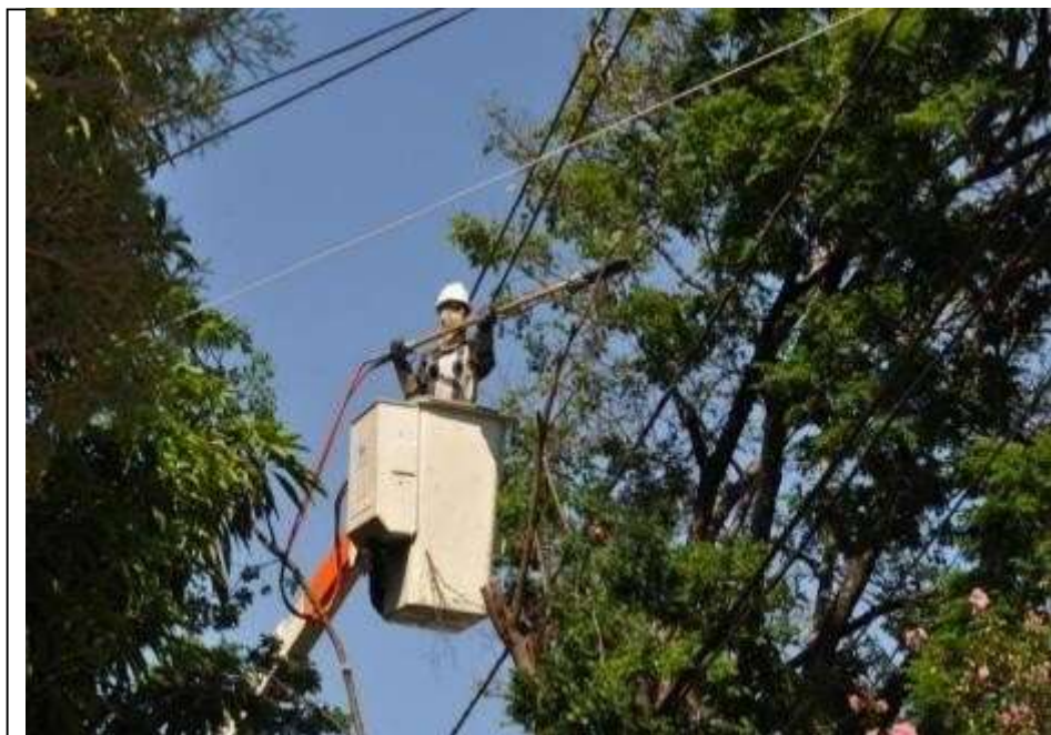
Figura 4: ELV executor na atividade de poda de vegetação.
