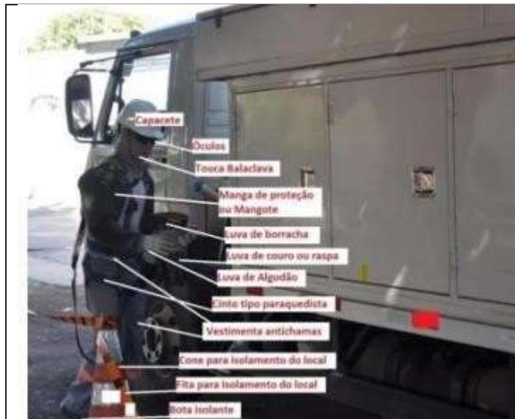
Figura3: ELV paramentado com os EPIs para a realização da atividade de poda de árvores
